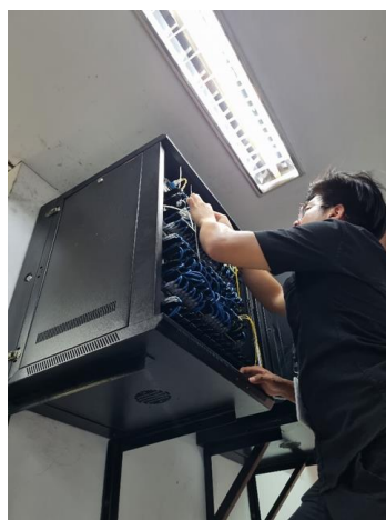
Gambar 14. Pemasangan Switch ke Rak Server
